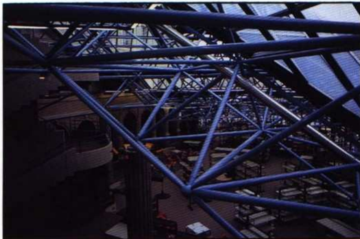
Bibliothèque municipale, Nevers. Arch. D. Froidevaux.
